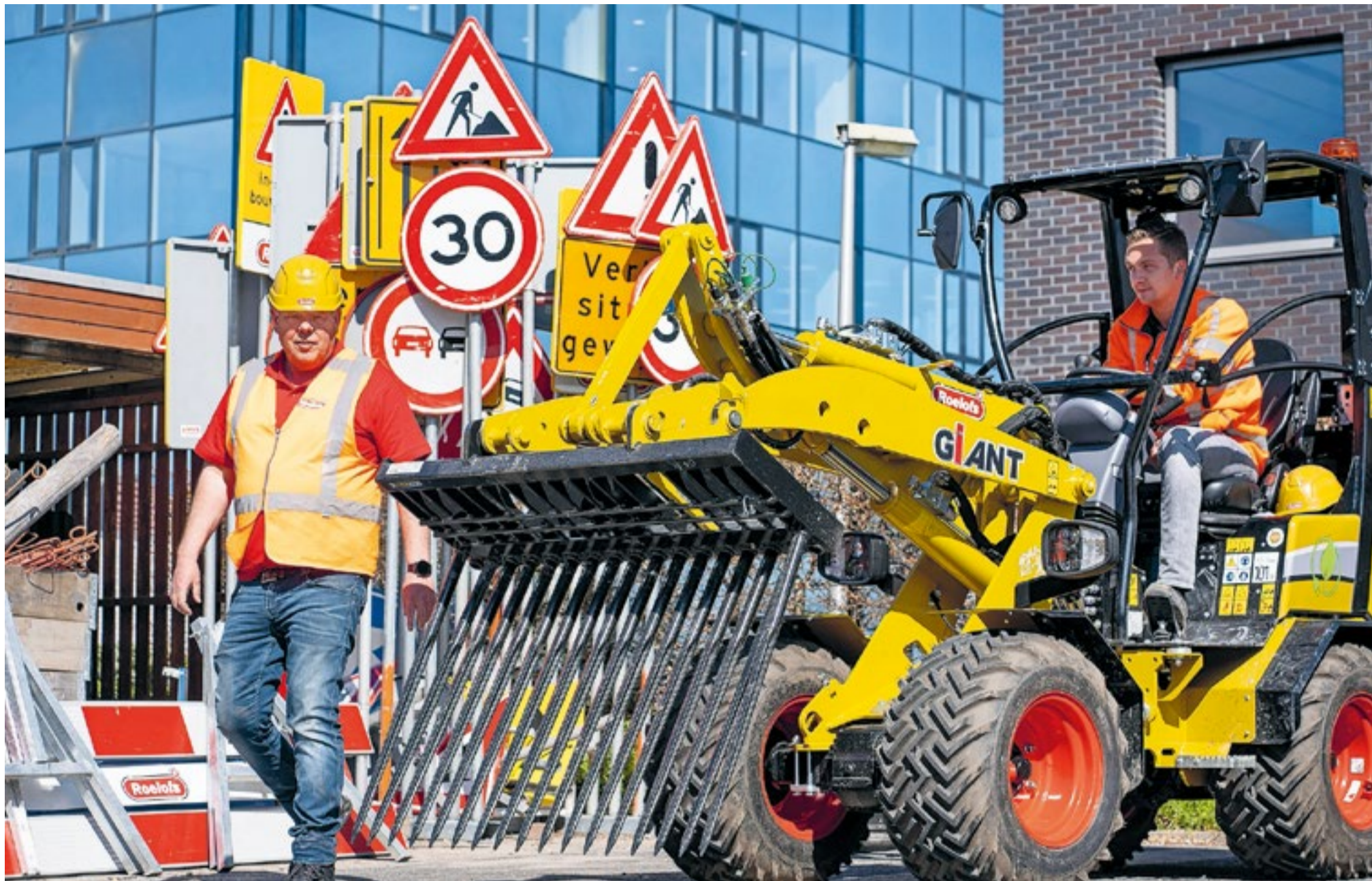
De shovel kan onder meer worden gebruikt om putten en in het wegdek verzonken palen te tillen (links). Met een zogeheten riebak wordt bestrating uitgegraven (rechts).
